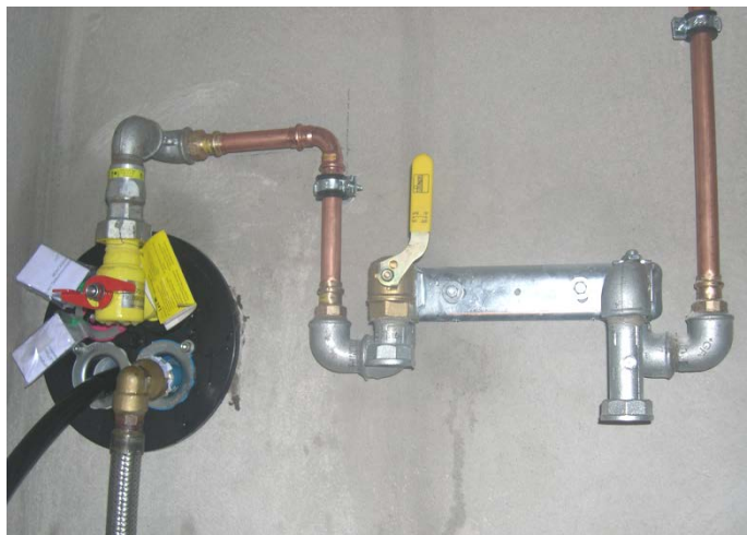
Abbildung 8.2: Gaszähler-Anschlussplatte
