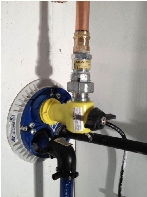
Abbildung 5.3: Beispiel einer Mehrsparten Hauseinführung
