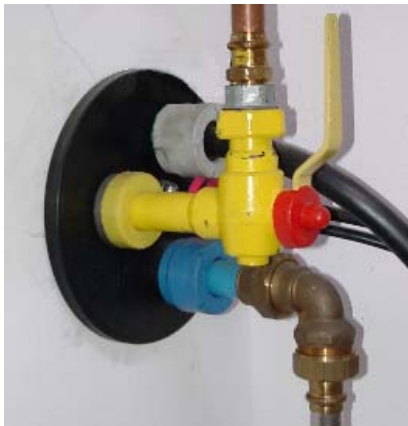
Beispiel: Mehrsparten Hauseinführung
