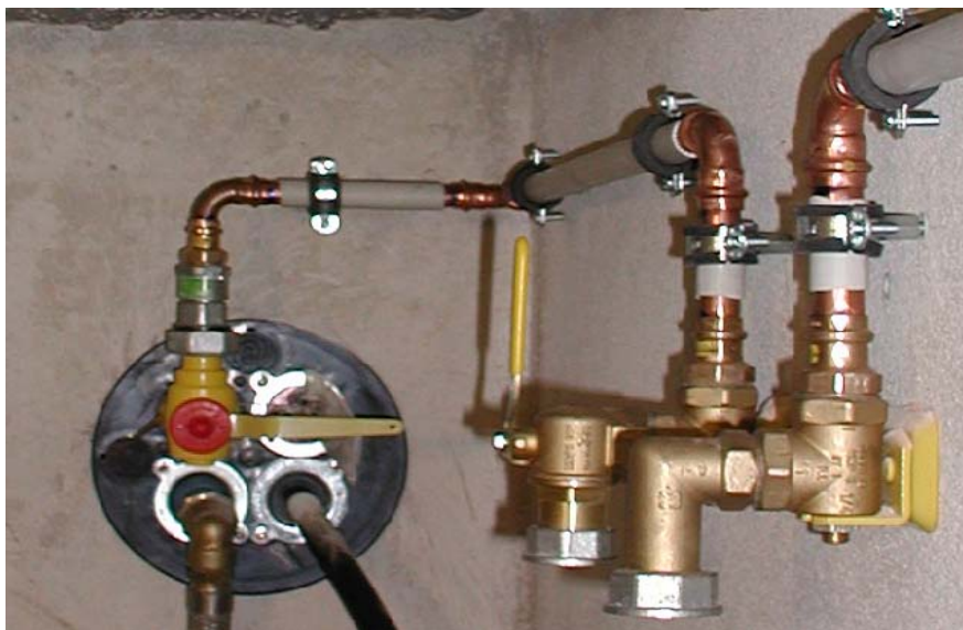
Anschluss einer Gaszähler-Anschlussplatte
