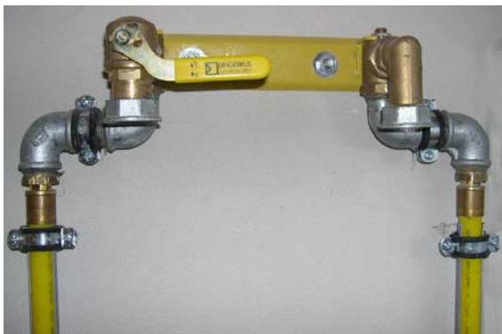
Gas-Zähleranschlussplatte – Anschluss mit nicht metallenen Leitungen
