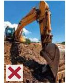
Kein Bagger-Einsatz in direkter Nähe von Versorgungsleitungen
